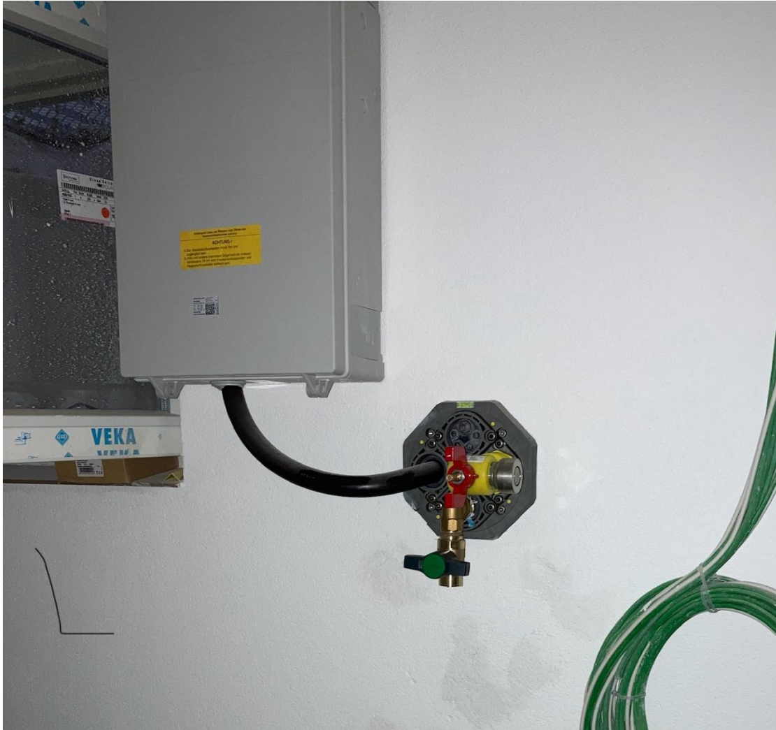
Abbildung 2 Mehrspatenhauseinführung durch die Wand
