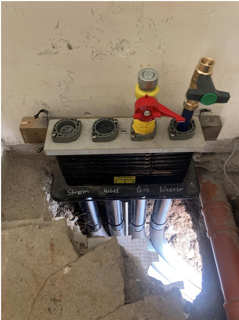
Abbildung 1 Mehrspartenhauseinführung durch die Bodenplatte
