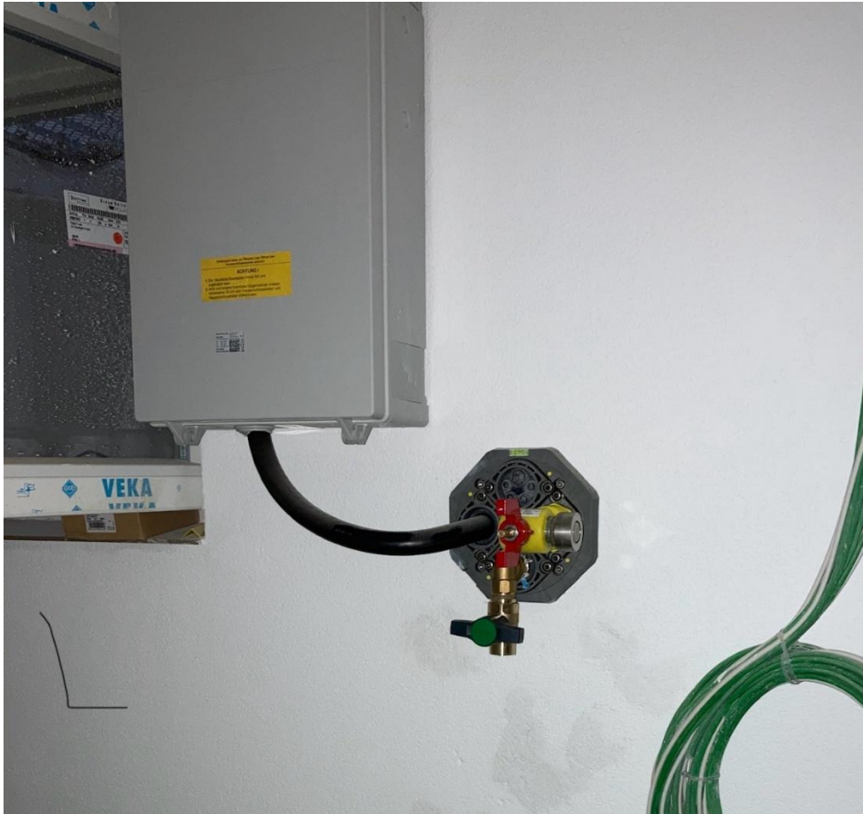
Abbildung 2 Mehrspatenhauseinführung durch die Wand
