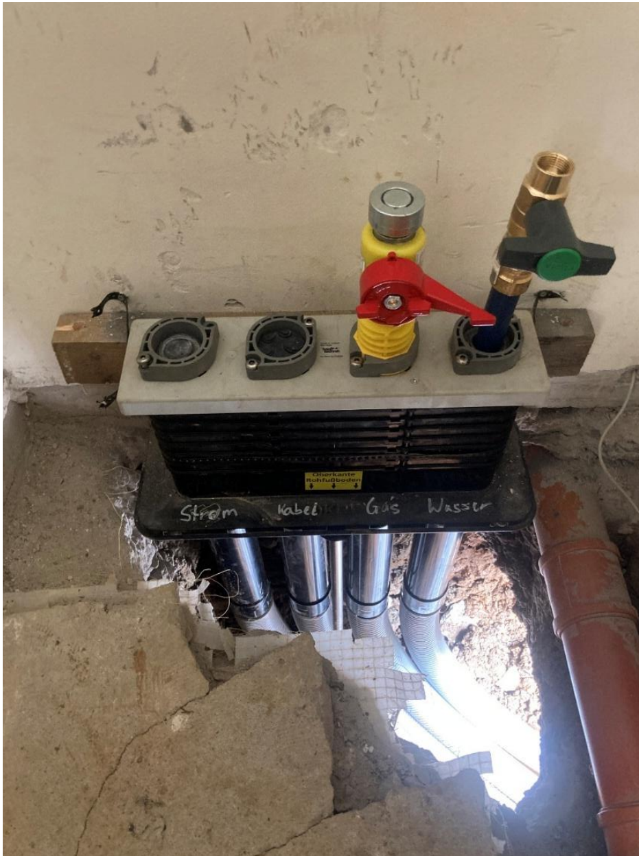
Abbildung 1 Mehrspatenhauseinführung durch die Bodenplatte
