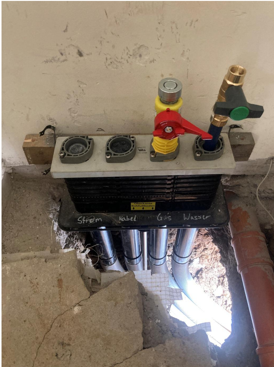
Abbildung 1 Mehrspartenhauseinführung durch die Bodenplatte
