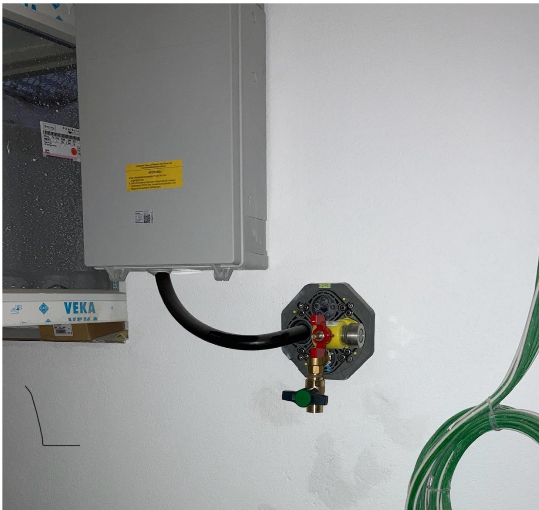
Abbildung 2 Mehrspatenhauseinführung durch die Wand
