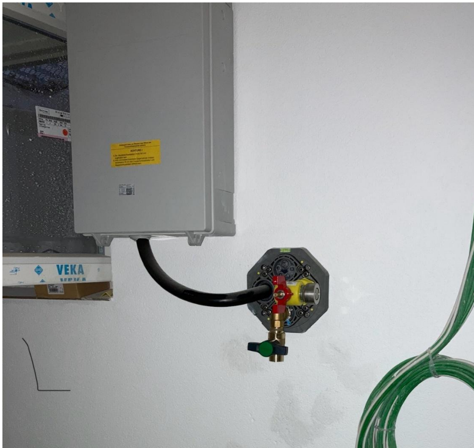
Abbildung 3 Mehrspatenhauseinführung durch die Wand
