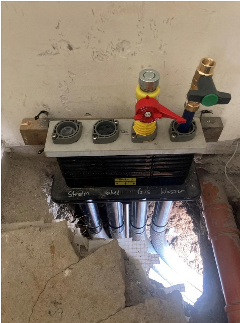
Abbildung 2 Mehrspartenhauseinführung durch die Bodenplatte
